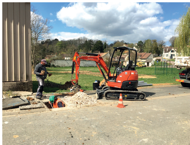
Travaux effectuées par la SAUR pour l'accès à l'eau dans les jardins partagés
